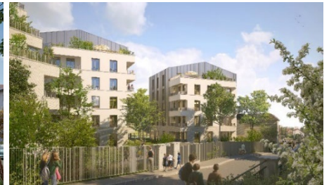
14-18, rue Raymond Poincaré à Sceaux (92)
